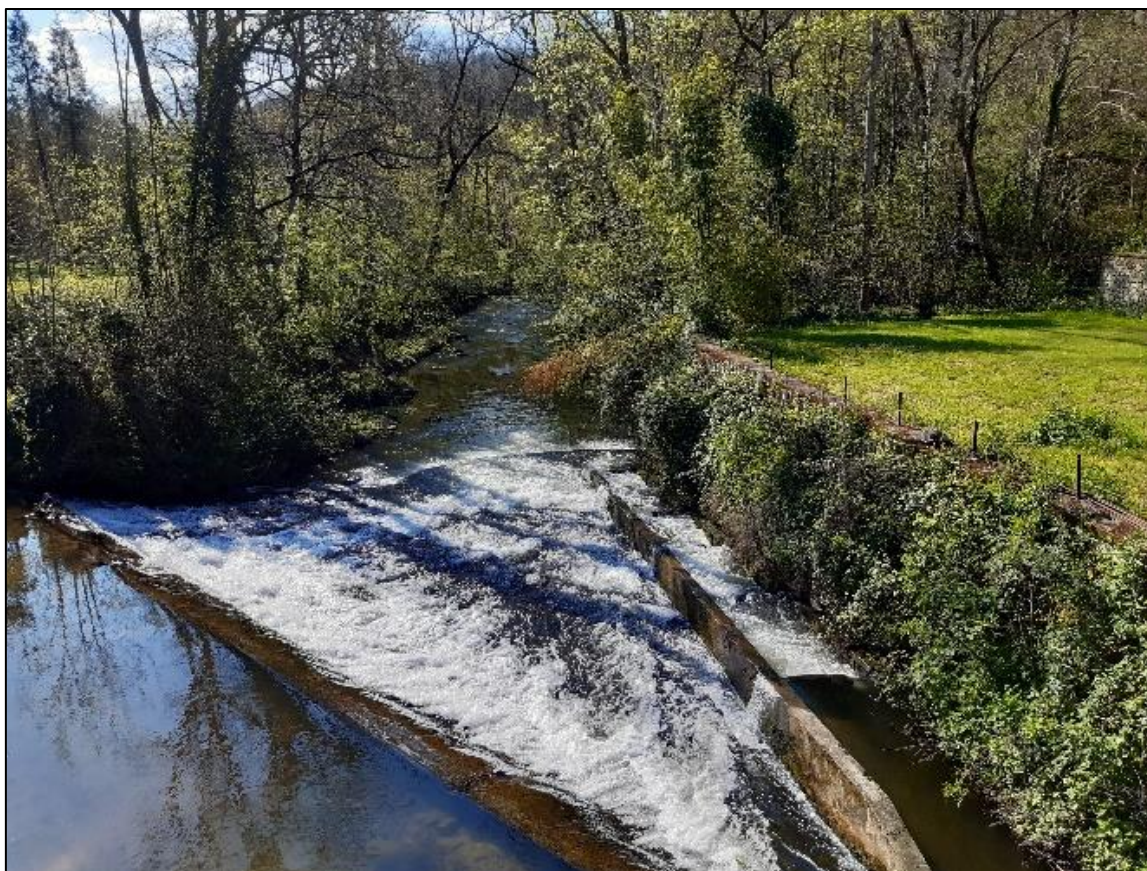
Figure 16 : Vue des débordements le 18/04/2023
