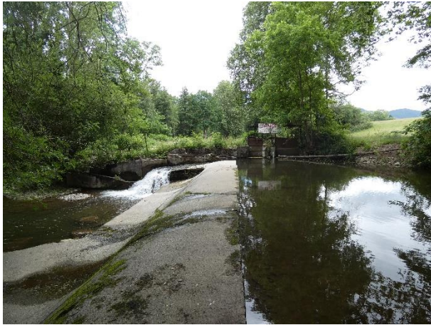
Environnement paysager au droit de la prise d'eau
