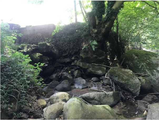
Canal de décharge
