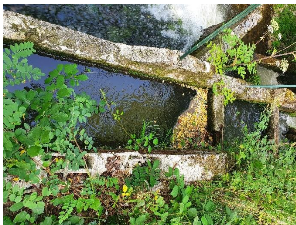
Chenal amont et cloison 1
