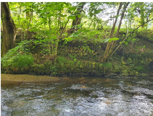
Enrochement ponctuel en rive gauche
