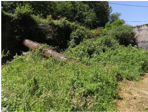
Lisières eutrophiles mésohygrophile et friche rudérale héliophile de part et d'autre de la canalisation
