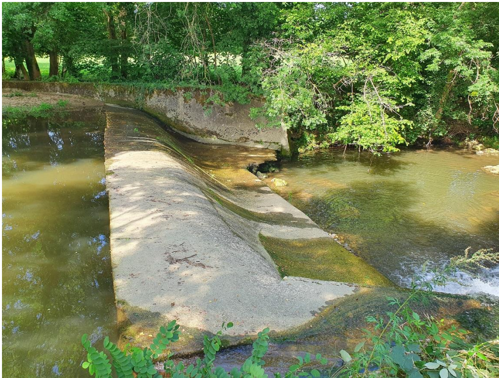
Seuil de répartition de la centrale de Ruffié
