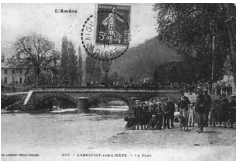
Photographie 8 : Le pont de la Bastide-sur-l'Hers au début du 20 ème siècle.
