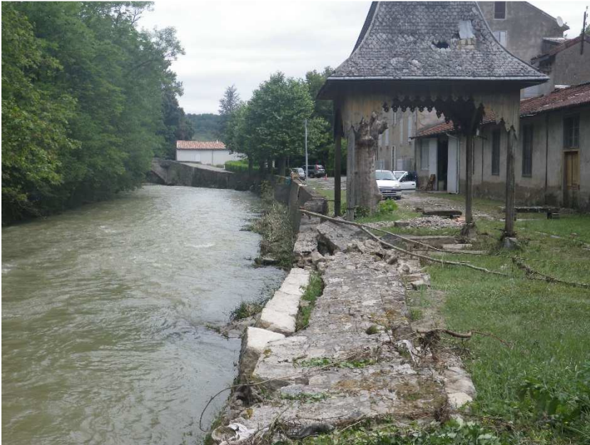
Photographie 10 : Rive droite à l'amont du pont de Fontcirque (Source : Agerin)
