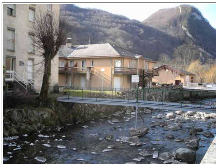
Vue des thermes (bâtiments saumon), on notera les ouvertures de plain-pied.
