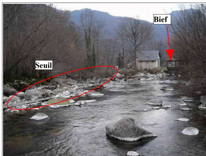
Prise d'eau sur le GARBET au droit du village.
