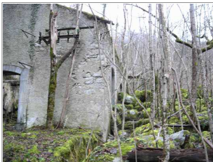
Ancienne centrale électrique située en rive droite du FOUILLET, on notera le volume important de blocs déposés par le torrent contre la façade.
