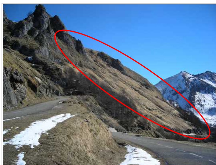
Vue des couloirs EPA 10, 11, 12 près du col d'AGNÈS. On notera la forte pente herbeuse.
