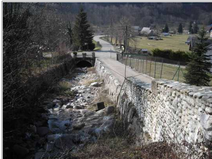
Chenal élargi du torrent de RIBAUT, on notera en rive droite le mur de pierres maçonnées vulnérable aux écoulements. On distingue en arrière plan le pont de la RD8f. A l'amont de cet ouvrage, le lit est équipé de seuils (non distinguables sur la photo).
