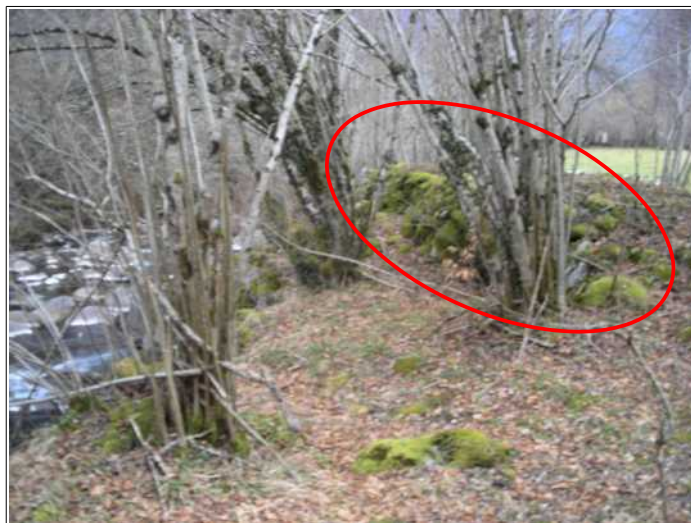
Mur de pierres visible en rive droite, 200 mètres à l'aval de la centrale électrique.
