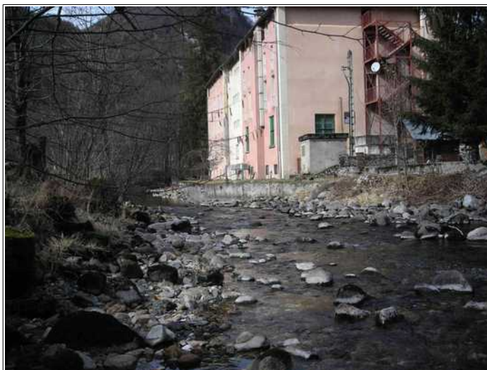
Vue du bâtiment de la colonie situé dans l'axe d'écoulement du GARBET. On remarquera le déport du torrent sur la rive gauche.
