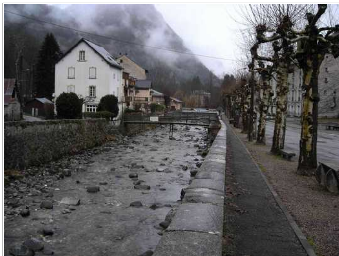
Vue en enfilade des passerelles enjambant le GARBET à l'aval de la route du col de LATRAPE. On notera les poteaux centraux des passerelles et la proximité du bâti.
