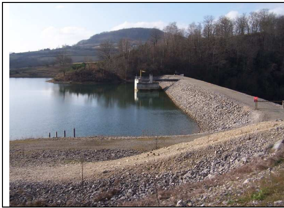
Le barrage de Filhet
