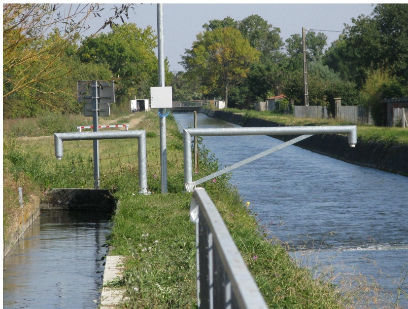
Le canal principal et le départ du canal secondaire du Gascon, deux sondes de mesures par ultrason.
