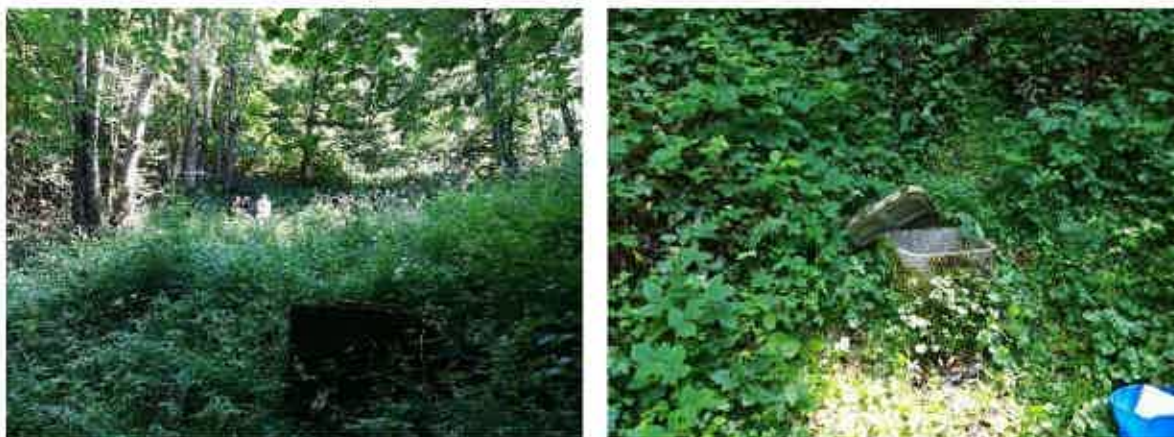
Illustration 15 : Clichés du captage de « Lamousquière Cap réservoir » (Source : CEREG, 2019)
