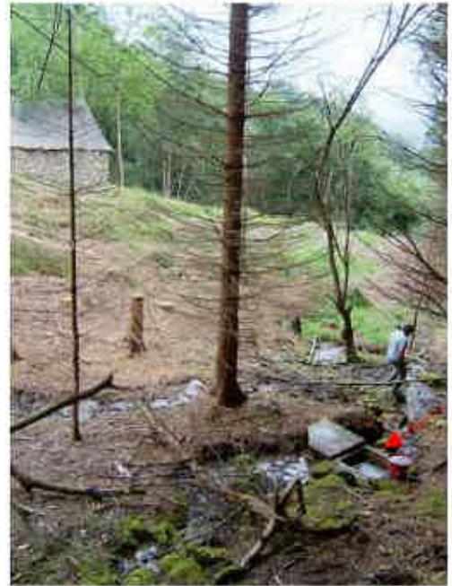
Vue en direction de l'aval, l'ouvrage de collecte est indiqué par la flèche
