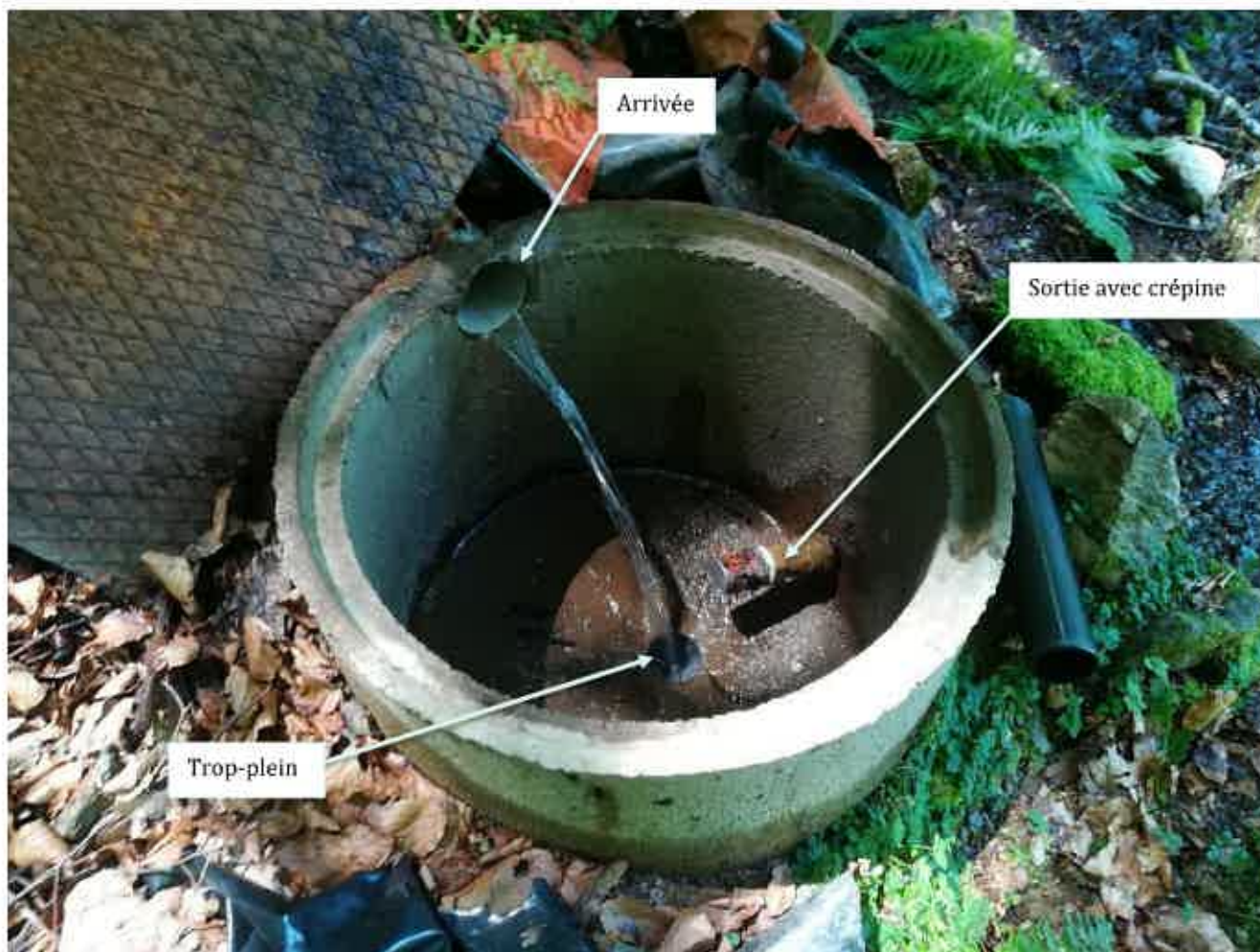
Illustration 17 : Cliché de l'intérieur du captage de « Paillol » (Source : CEREG, 2019)
