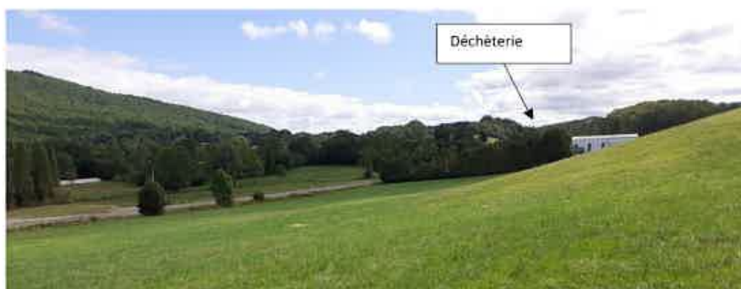
Photographie 4 : Vue depuis l'habitation la plus proche à l'Ouest de la déchèterie. On distingue le bâtiment, anciennement le quai de transfert. Le reste de la déchèterie est masqué par un écran arboré en bordure du site.
