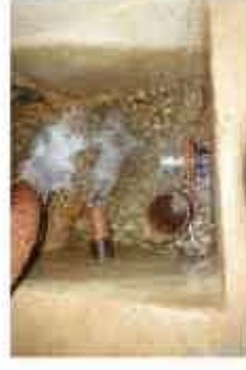
Vues des galeries drainantes, des arrivées des captages amont et du départ réseau.
