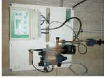
Dispositif de la chloration gazeuse au réservoir de Castillon
