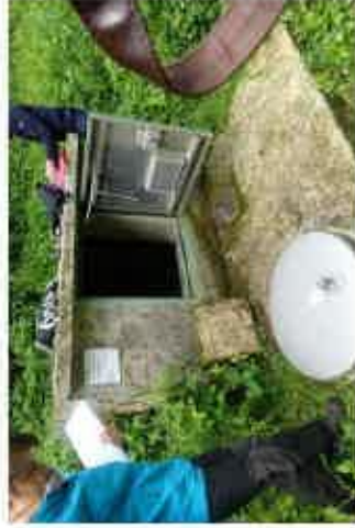
Captage 2 ouvert, Captage 1 et 1bis au sol (fermés)
