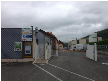
Entrée du site
