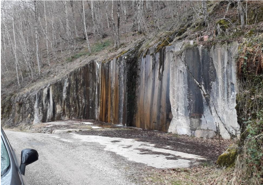
Figure 1 Vue actuelle du site de la carrière
