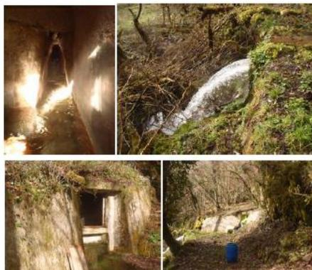
Figure 2 : Situation du captage (Photos du 29/03/2018) : Zone d'émergence (en haut à gauche) et débit de trop plein (en haut à droite) ; ouvrage de captage (en bas)
