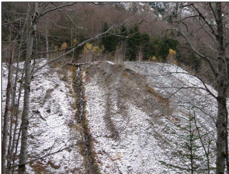
Figure 39 - Photo de la verse à stériles du niveau 1320 montrant le ravinement en cours et la « carapace » ferrugineuse partiellement érodée
