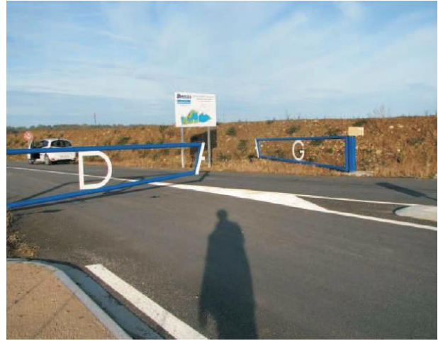
Portail à l'entrée du site pour le contrôle de l'accès
