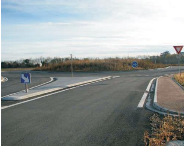
Accès au site par le giratoire sur la RD 820
