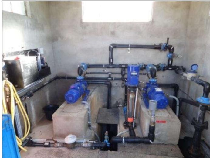
Figure 10 : Local technique du puits AMARA avec les 3 pompes ©ETEN Environnement
