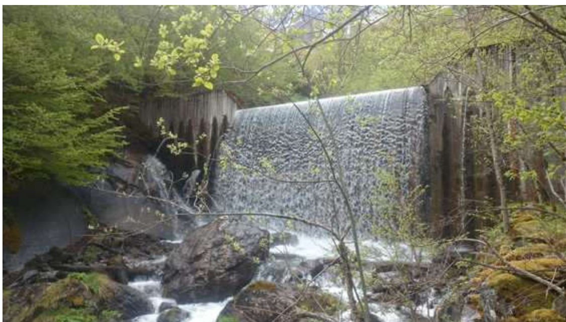
Barrage dans les gorges à l'aval duquel la vie piscicole est à nouveau présente
