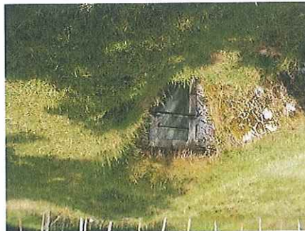
Figure 12 : réservoir de Conte
