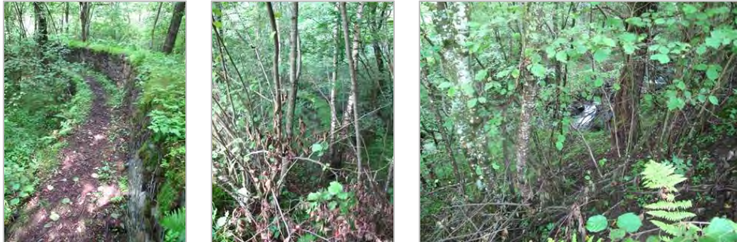
Figure 168 : Mur de confortement du dépôt « Aval laverie Nord » (GEODERIS, août 2013)
