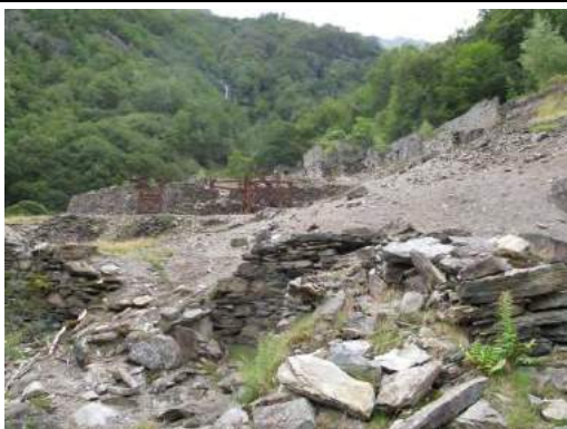
Vestiges bâtis et dépôts miniers associés (août 2010)
