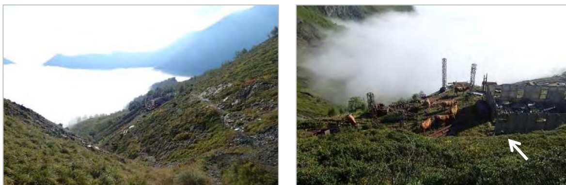
Figure 177 : Plateforme de Rouge située en bordure du GR10
