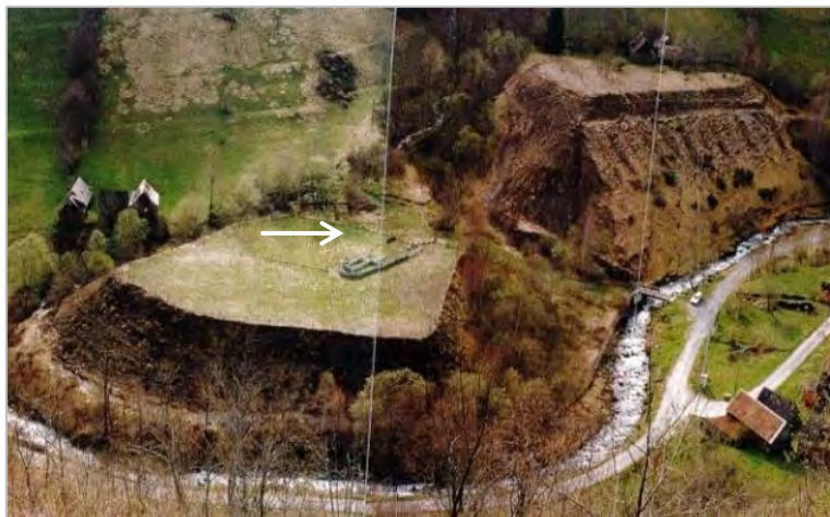
Figure 187 : Dépôt « Aval laverie Sud » et installation d'élevage (MICA Environnement, 2003)
