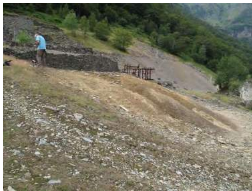
Résidus de décantation (août 2010)
