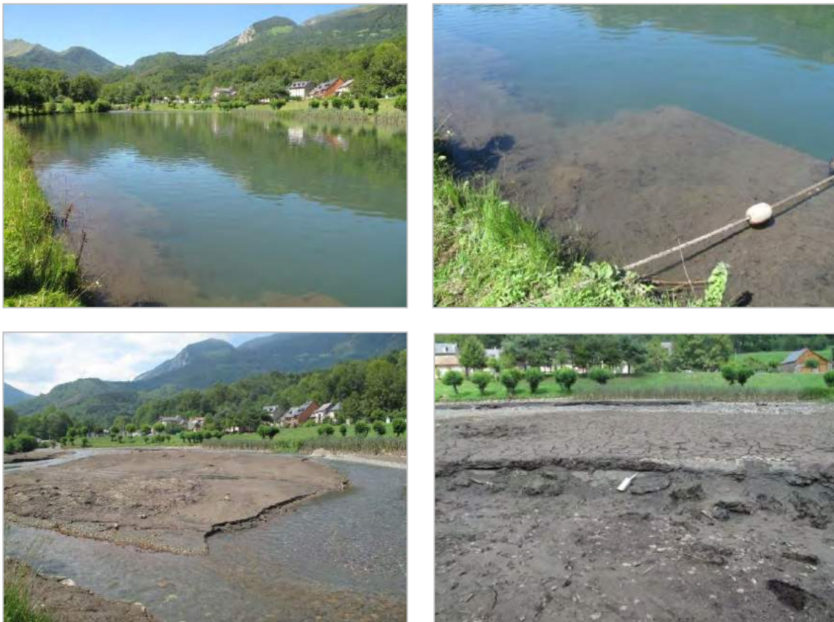
Figure 170 : Barrage de Bonac et matériaux fins sédimentés dans la retenue avant la vidange du 26/08/2013 (en haut) et après la vidange (en bas)
