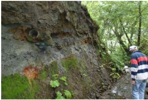
Flancs du dépôt avec alternance de niveaux sableux et de niveaux argileux (au nord) et affouillement par le ruisseau de Laspé (août 2013)
