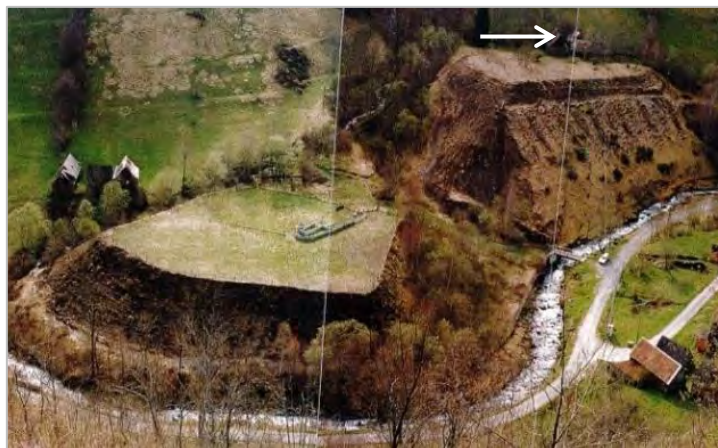
Figure 186 : Dépôt « Aval laverie Nord » et résidence temporaire (MICA Environnement, 2003)
