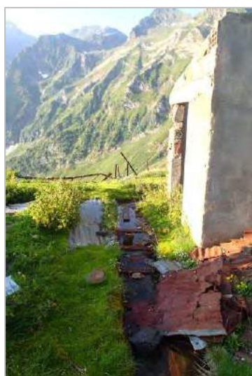
Emergence du travers-banc Saint-Jean devant l'entrée de l'ouvrage
