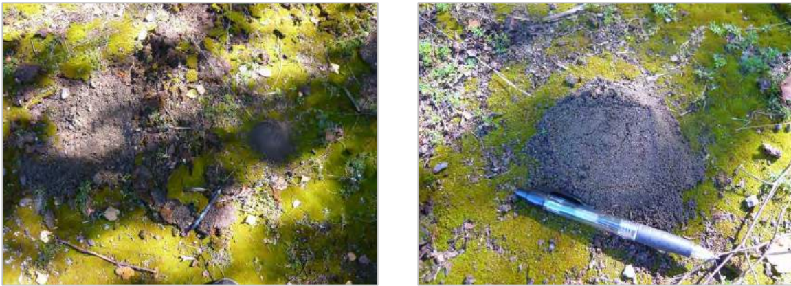
Figure 199 : Matériaux résiduels en surface au droit de la parcelle 1964
