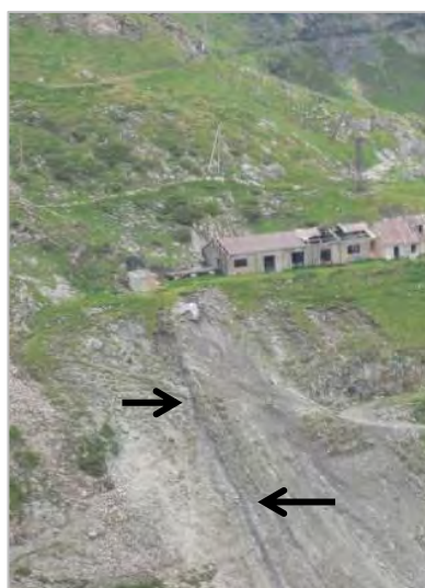
Drain formé par l'émergence minière au droit du dépôt de stériles miniers associé au travers-banc
