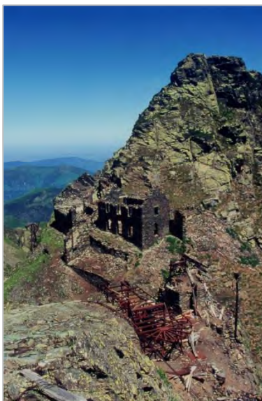
Habitat, la station de recette des va-et-vient, la station de tête du monocâble et son premier pylône (vue depuis le sud)
