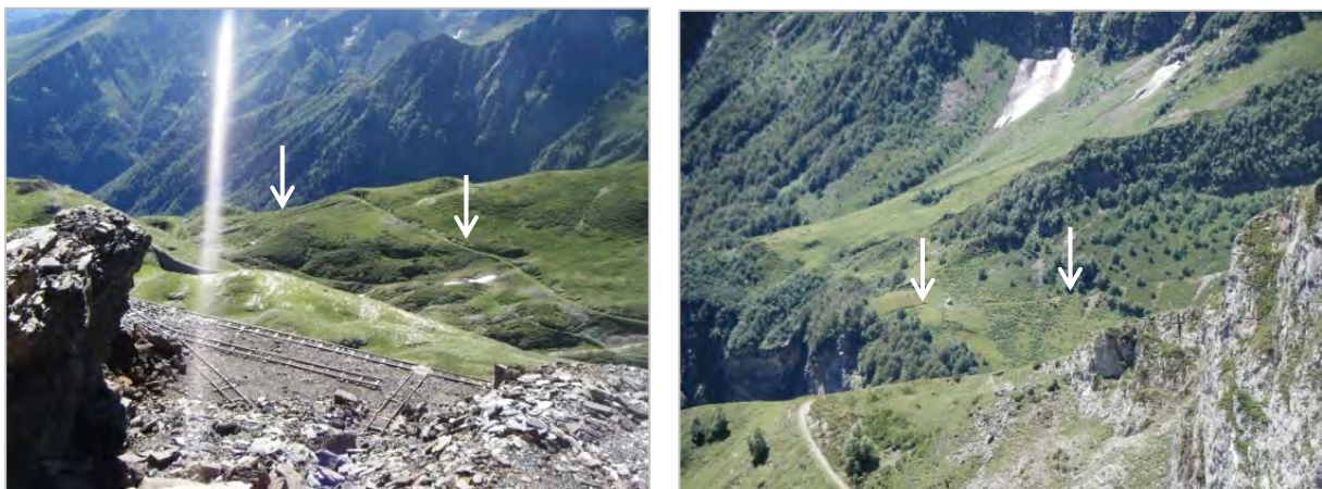
Figure 54 : Vestiges actuels des installations ferrées menant des travaux miniers au départ de la glissière hydraulique (à gauche) et de la glissière hydraulique, dans les environs du refuge de Sans (à droite)
