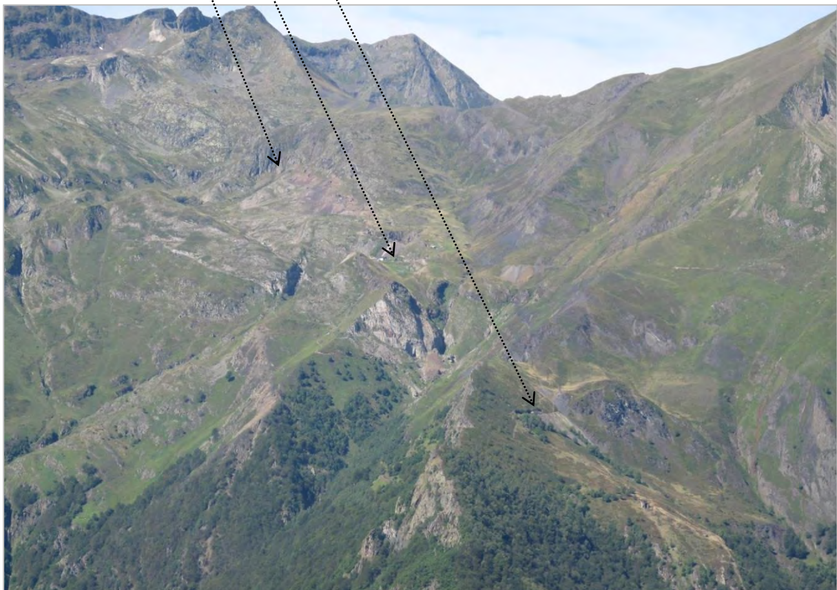
Figure 51 : Situation des sites miniers sur la concession de Sentein (en haut ; carte sur fond SCAN 100 ©IGN) et mise en évidence des chantiers d'exploitation (GEODERIS ; 2010)
