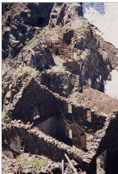
Habitat et station de tête du monocâble Etcheverry. À gauche de celle-ci, station de recette des va-et-vient de la mine.
