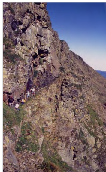
Ancienne voie de roulage
