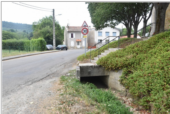
Figure 3.13: franchissement de la route du village par le ruisseau du Gabre.
