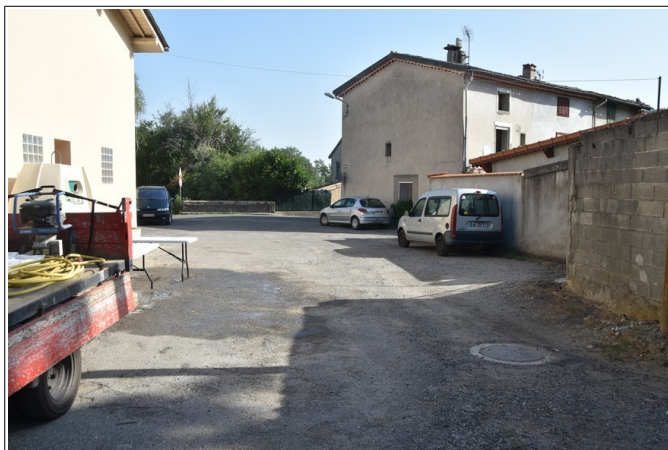
Figure 3.15: cour des services techniques inondable par le ruisseau de Piteil.
