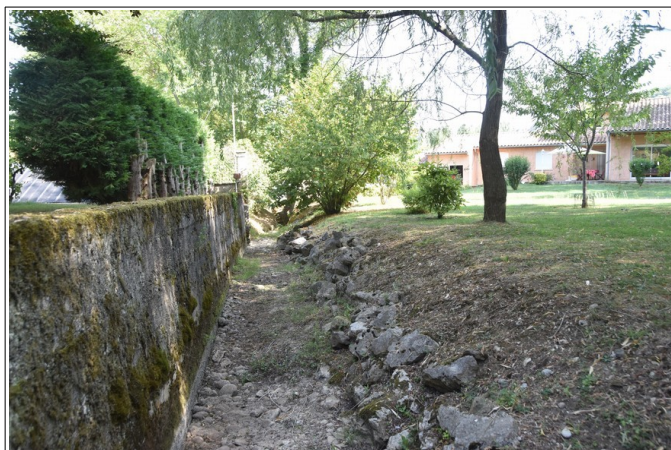
Figure 3.17: propriété bâtie à l'aval de l'ancienne voie ferrée.
