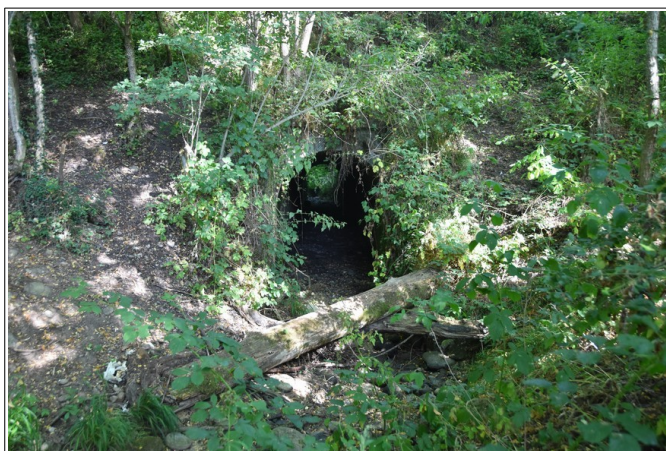
Figure 3.14: Franchissement de l'ancienne voie ferrée par le ruisseau de Piteil. On notera la présence de bois mort dans le lit.
