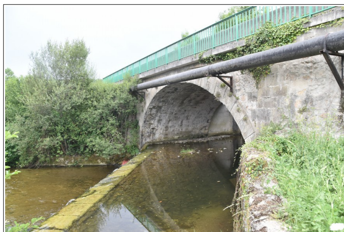
Figure 3.7: pont de la RD625 et son seuil (ancienne prise d'eau aménagée sur le Touyre).
