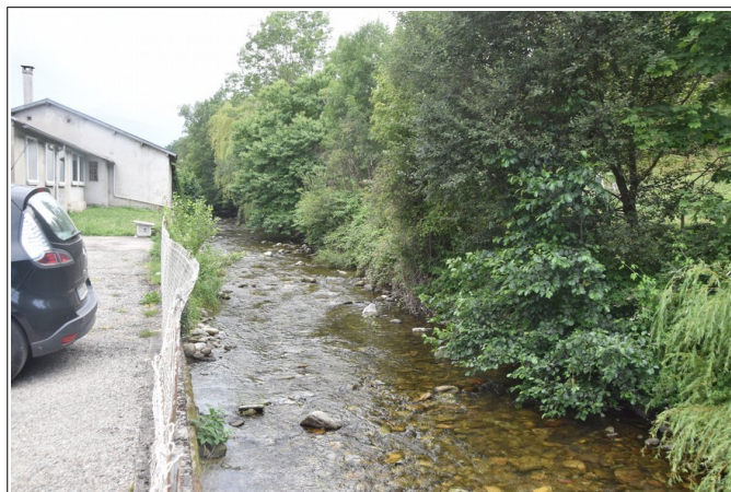
Figure 3.6: le Touyre au niveau de la zone commerciale (vue vers l'amont). A ce niveau, il peut déborder en rive droite (à gauche sur la photo).
