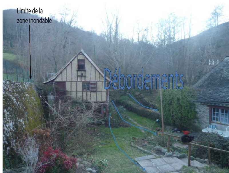
Figure 5 : Débordements au niveau des habitations à Tournac (source : AGERINsas)
