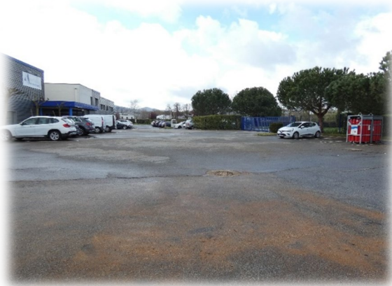
Zone bétonnée légèrement pentue (© ECTARE - 16/03/2021)
