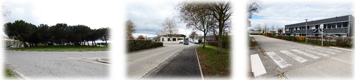
Illustration 24 : carrefour giratoire - entrée de la zone Delta Sud (à droite - © Maps), rue Marie Curie (au centre) et Rue Louis Pasteur (à droite) – (© ECTARE)
