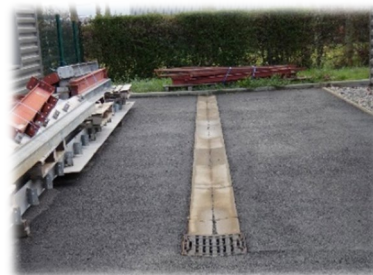
Caniveau et grille sur la zone de stockage
