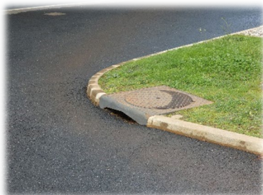
Avaloir sur la zone de stationnement
