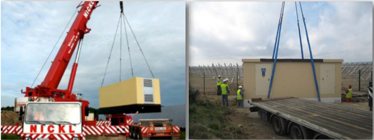
Pose d'un poste de livraison
