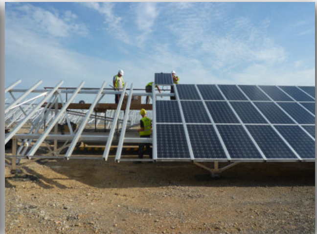
Pose des panneaux photovoltaïques
