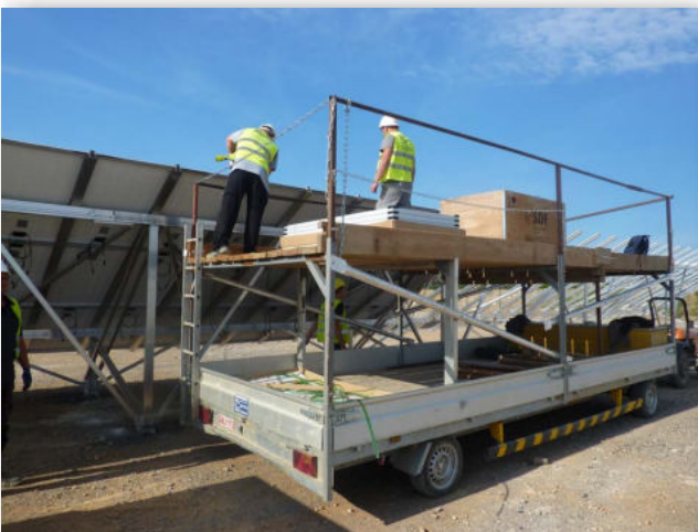
Pose des panneaux photovoltaïques
