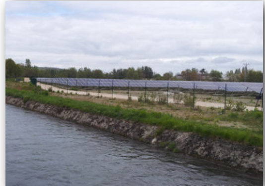
Exemple de clôture
