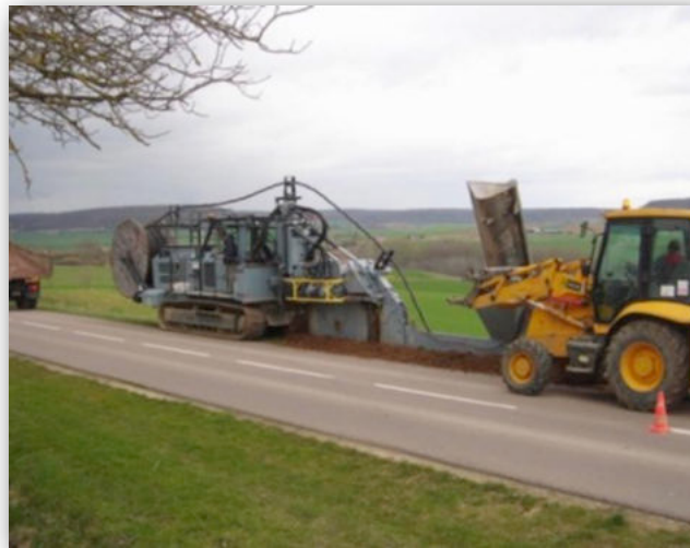
Pose du câble de raccordement
