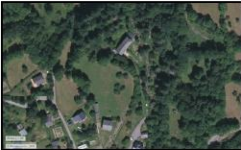
Figure 1 Vue aérienne de l'installation
