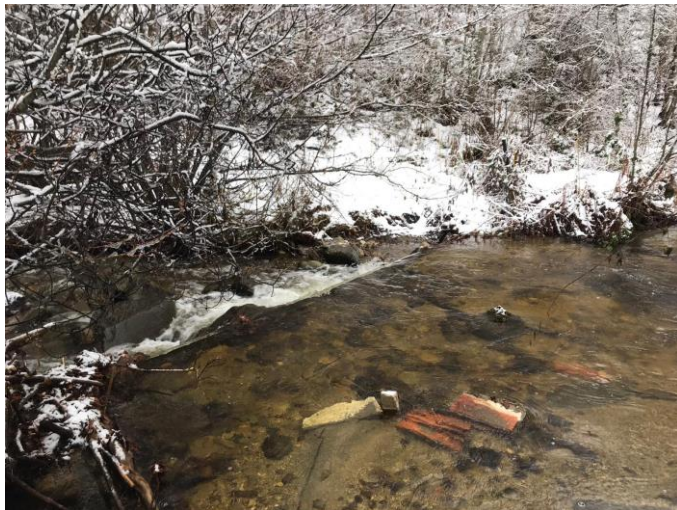
Le seuil de prise d'eau sur la rivière de Quérigut
