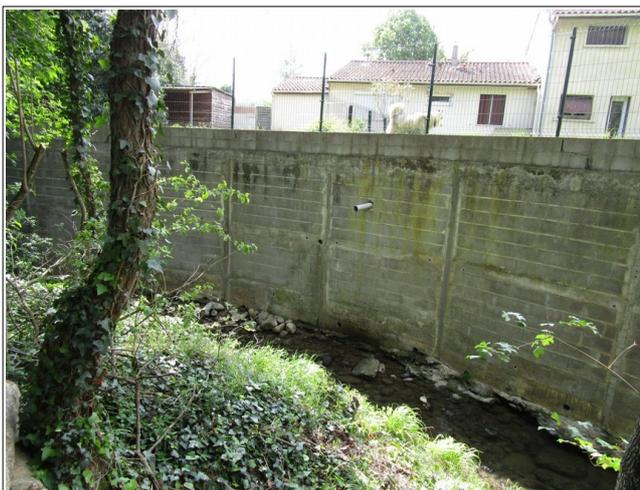
Figure 3.20: confortement de la rive gauche du ruisseau de Lansonne au lieu-dit la Sarraillère ; une déstabilisation de l'ouvrage n'est pas à exclure.
