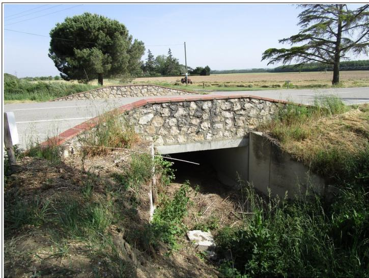
Figure 3.12: ouvrage hydraulique de la Galage sous la RD14 ; on notera sa faible ouverture.
