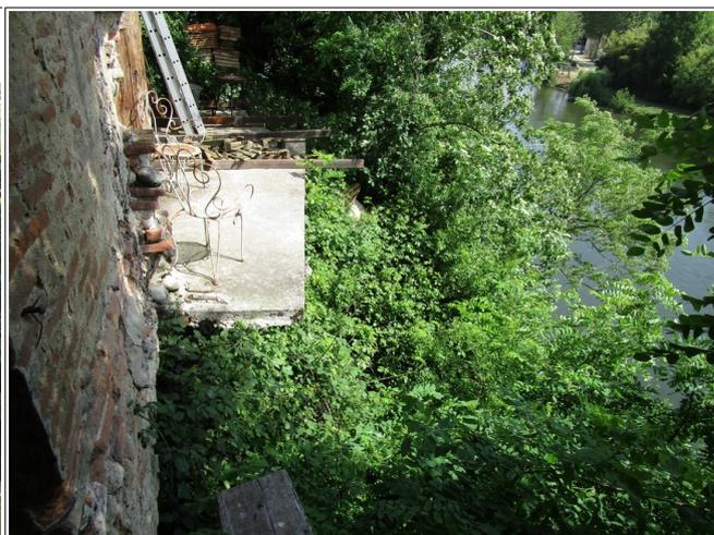
Figure 3.53: vue de la berge au ras des maisons ; le trottoir au premier plan repose quasiment dans le vide.
