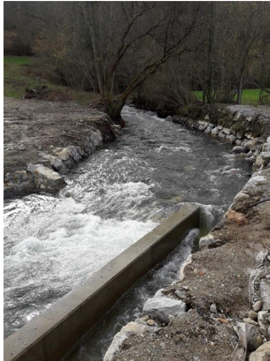
Figure 4 : L'Arget avec les seuils et la prise d'eau au droit de l'usine
