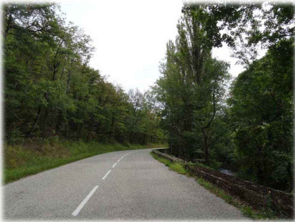
Figure 23 : photographie de la RD 7 et le muret protégeant l'Hers des ruissellements de la voirie
